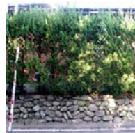
ユニット09E36付近
