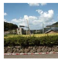
ユニット10E62付近
