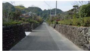
(7) 付近 (崩落点在箇所)
