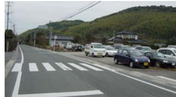
(4) 付近 (崩落集中箇所)
