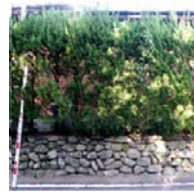
ユニット09E36付近
